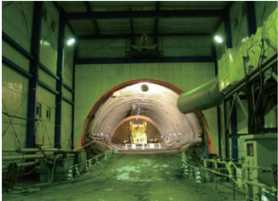
トンネル坑口防音対策 Anti-noise measures for tunnel entrances
