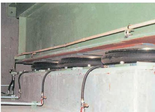
防振架台と空気バネ装置
