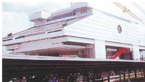
◀ 建築制振装置
