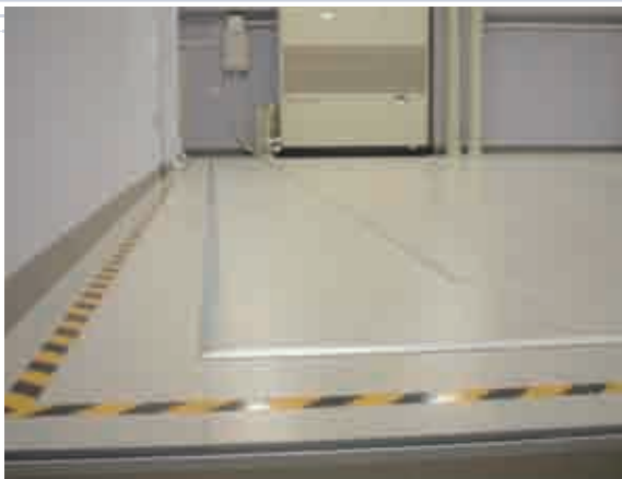
免震床仕上り
