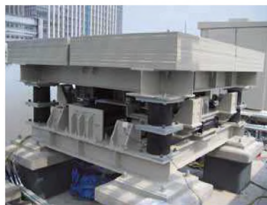
ビル屋上TMD
